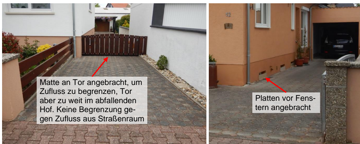
Abbildung 19 Auswahl vorhandener Objektschutzmaßnahmen in der Straße „Hinter den Gärten“
