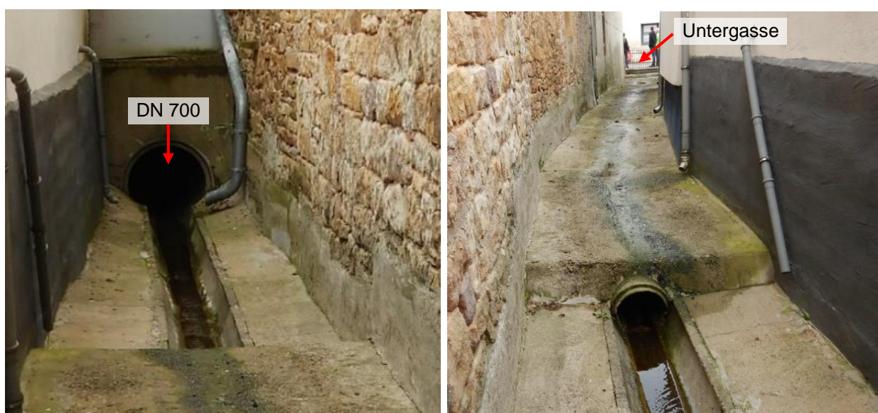
Abbildung 33 Entwässerungsgasse ehemaliger Tiefpunkt Untergasse
