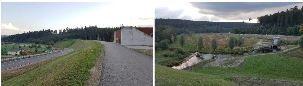
Abbildung 50 Beispiel Hochwasserrückhaltebecken Wolterdingen im Donau-Einzugsgebiet (max. Dammhöhe 18 m, Stauraum 4,7 Mio. m 3 , Bemessung auf ein 100-jährliches Hochwasser)
