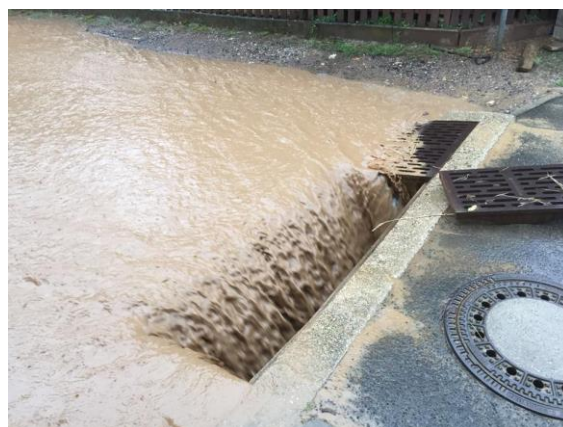
Abbildung 23 Ablaufrinne Lutherpfad 11.06.2018 (Quelle: Feuerwehr Offenheim)
