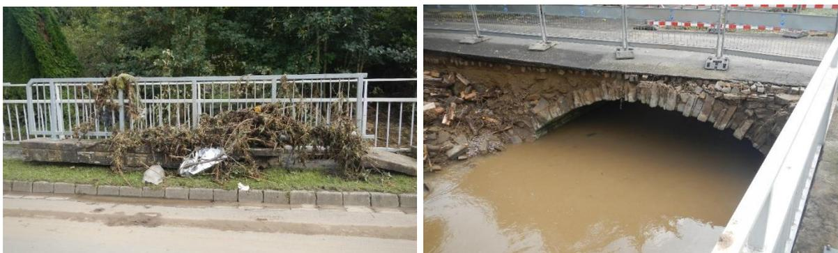
Abbildung 38 Treibgut und zerstörtes Brückengeländer infolge Wasserdrucks (Beispielbilder)
