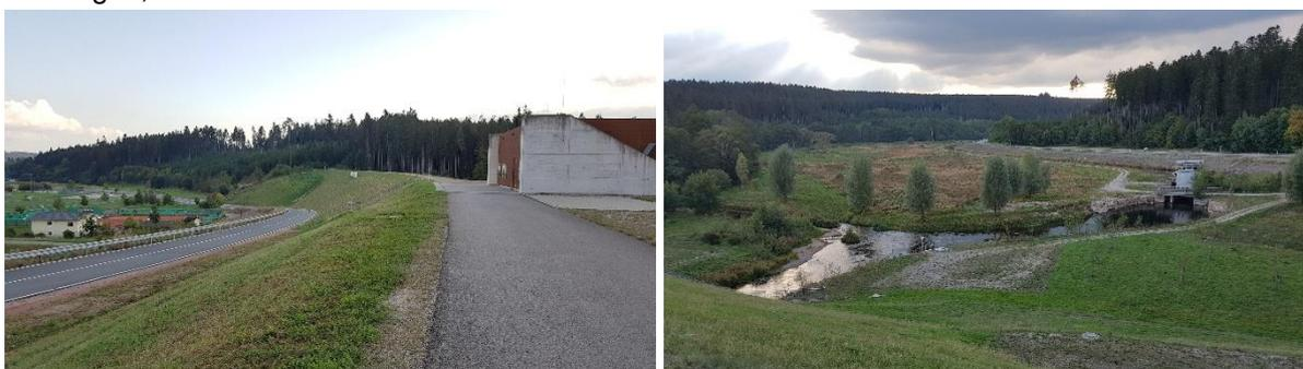
Abbildung 40 Beispiel Hochwasserrückhaltebecken Wolterdingen im Donau-Einzugsgebiet (max. Dammhöhe 18 m, Stauraum 4,7 Mio. m<sup>3</sup>, Bemessung auf ein 100-jährliches Hochwasser)
