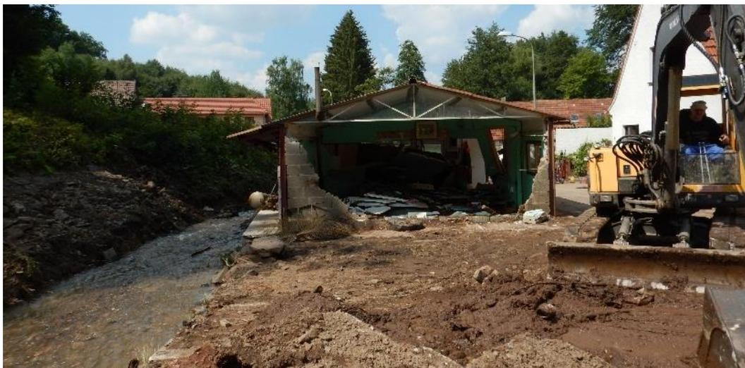
Abbildung 39 Eingestürzte Wand infolge Wasserdrucks (Beispielbild)
